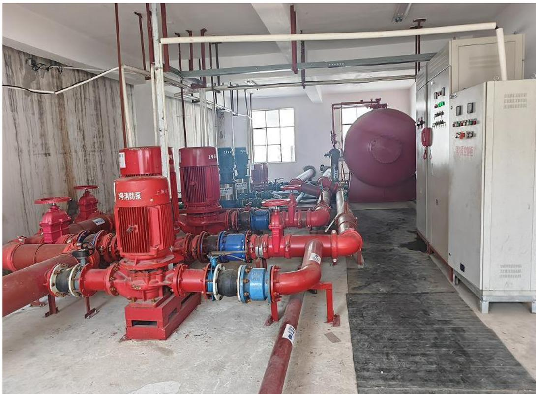
图 2-7 泡沫灭火装置
